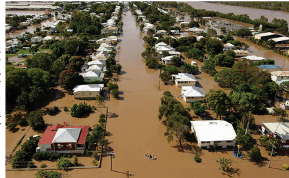
Vue aérienne des dommages causés par les inondations de 2011 à Brisbane
